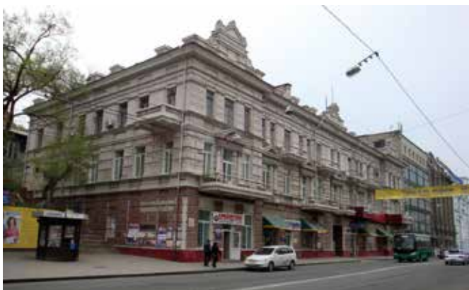
Рис. 10. Здание доходного дома братьев Пьянковых. Владивосток. Архитектор И.В. Мешков. 1900–1903 годы [9]
