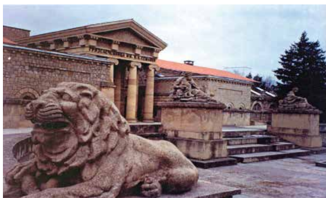
Грязелечебница. Архитектор Е.Ф. Шреттер. 1915 год. Город Ессентуки. Фрагмент комплекса
