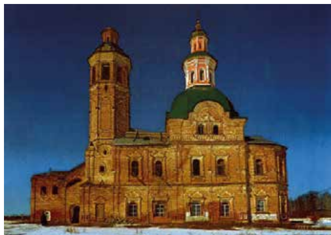
Рис. 6. Церковь Спаса Всемилостивого с отреставрированными куполом и барабаном в селе Вяз Кировской области
