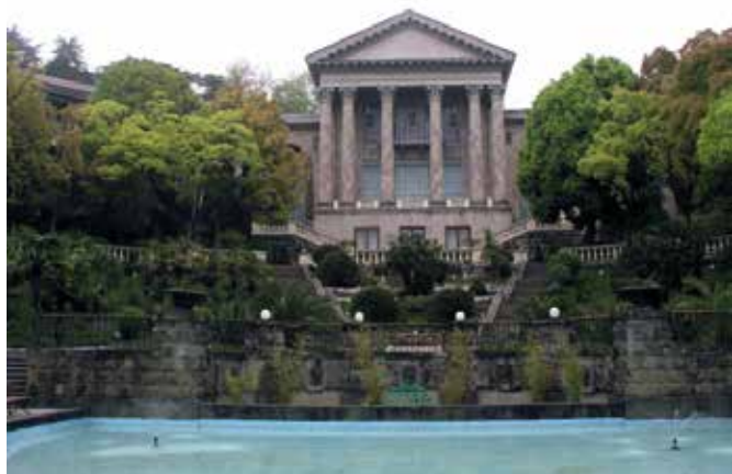
Рис. 9. Сочи. Курдонер и главный корпус санатория «Металлург» на Курортном проспекте. Архитекторы Я.О. Свирский, Г.Л. Битов. 1956 год. Фото В.В. Бондаря. 2012 год
